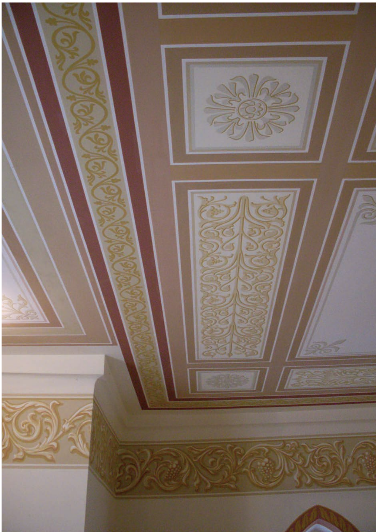
Fragment polichromii stropu i ścian nawy, fryz okalający Ceiling and walls polychromy, fragment, all round the frieze
