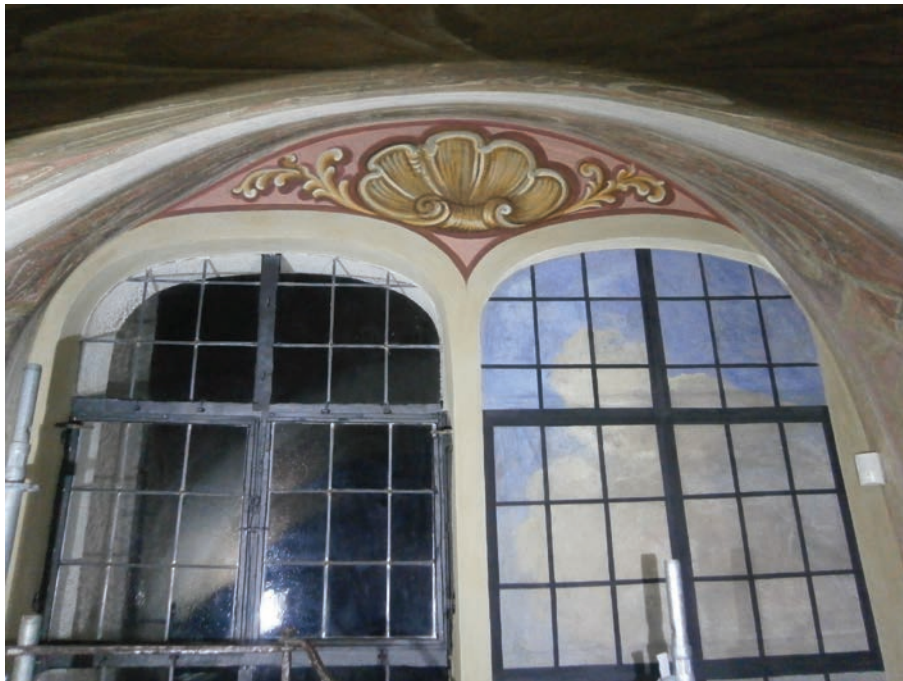
Polichromia po zakończeniu prac / Polychromy after finish of works
