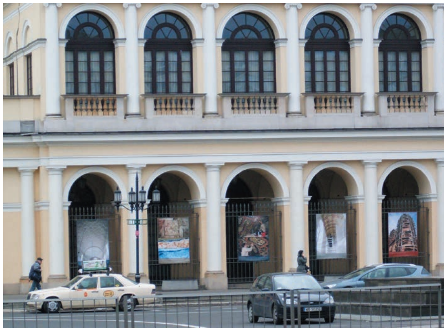
„Brochów. Rewitalizacja kościoła parafialnego pw. ŚŚ. Jana i Rocha miejsca chrztu Fryderyka Chopina w 200 rocznicę urodzin kompozytora”, Pl. Bankowy, Warszawa, 2010
