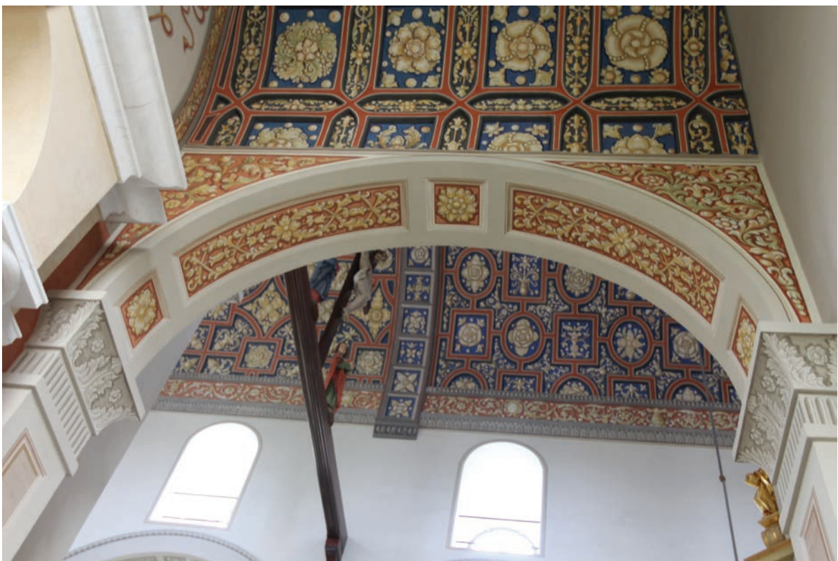
Polichromia arkad i sklepienia (pilastry, żagielki, podlucza, kasetony: rozety, liście akantu, dekoracje ornamentalne, płyciny) / Polychromy of arches and vault (pilasters, spandrels, underarches, coffers: rosettes, acanthus leaves, ornamental decorations, panels)
