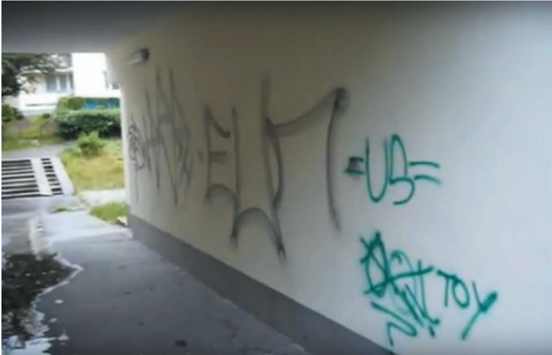
Widok ściany przed realizacją / View on wall before realisation
