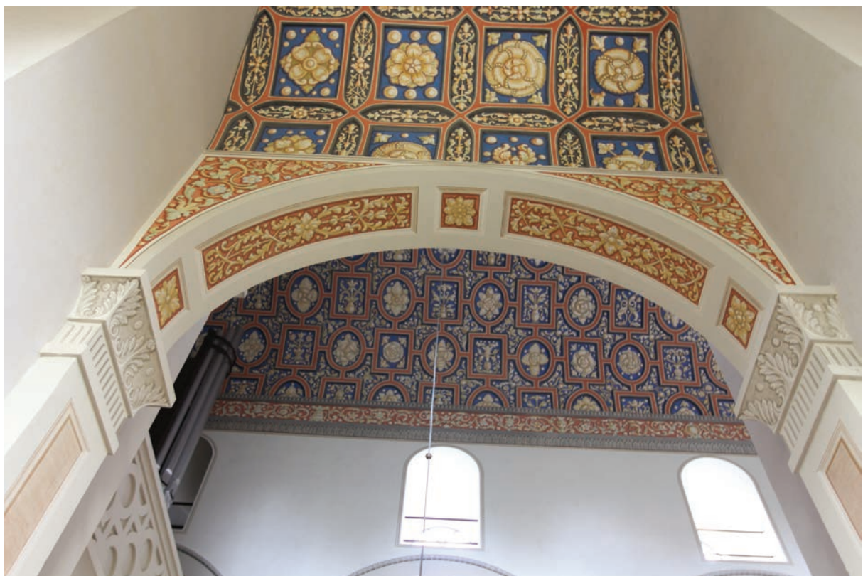
Polichromia arkad i sklepienia (pilastry, żagielki, podlucza, kasetony: rozety, liście akantu, dekoracje ornamentalne, pliciny) / Polychromy of arches and vault (pilasters, spandrels, underarches, coffers: rosettes, acanthus leaves, ornamental decorations, panels)
